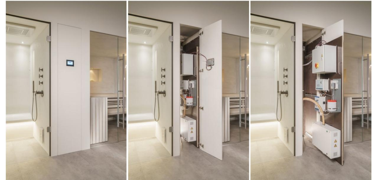
Schranktüre untergebracht. Sie hat einen 4,3 Zoll großen Touchscreen mit Unterputzkasten und zwei Temperaturfühler mit fünf Metern PVC-Anschlussleitung. Damit lassen sich folgende Funktionen ansteuern: Dampfgenerator, Abluftventilator, Duftstoffpumpe, Impuls-Pausenzeit, Scheinwerfer, Linelights und Bankheizung. Außerdem erfasst sie Raumtemperatur und Banktemperatur.
